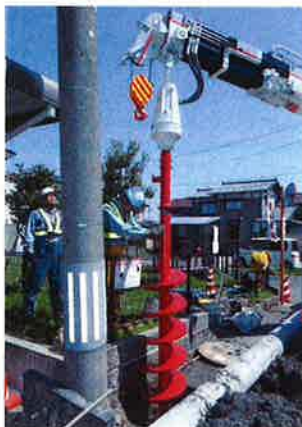
バッテリー駆動のオーガによる掘削作業
