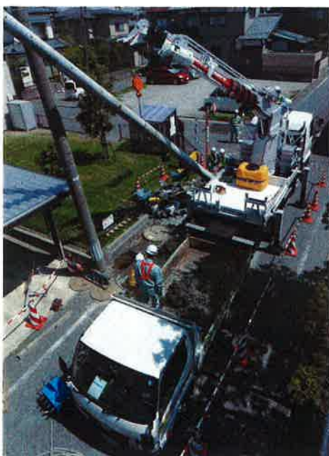
音には気がつかう住宅街の作業だが、D70Aハイブリッド仕様の導入で作業員の精神的負担を軽減
