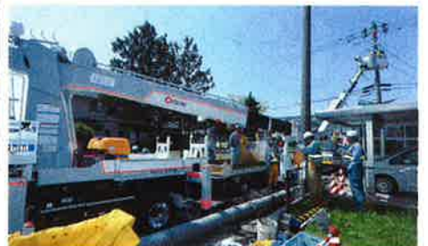
D70Aハイブリッド仕様と高所作業車、排土を運ぶトラックが連携した、建柱と撤去工事の様様
